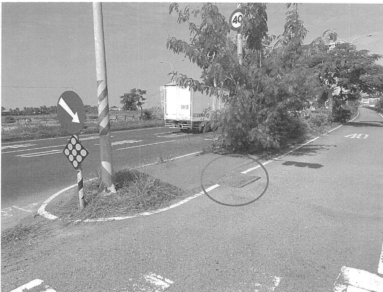
原規劃南科 CMS 門架遷移位置,與台電手孔牴觸情現況
